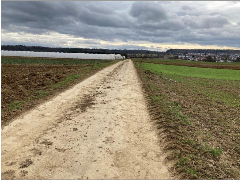
Abb. 12: Zuwegung Flst. Nr. 1279: Asphaltierter Wirtschaftsweg (südlicher Abschnitt) (Foto: HPC AG, 07.02.2024)
