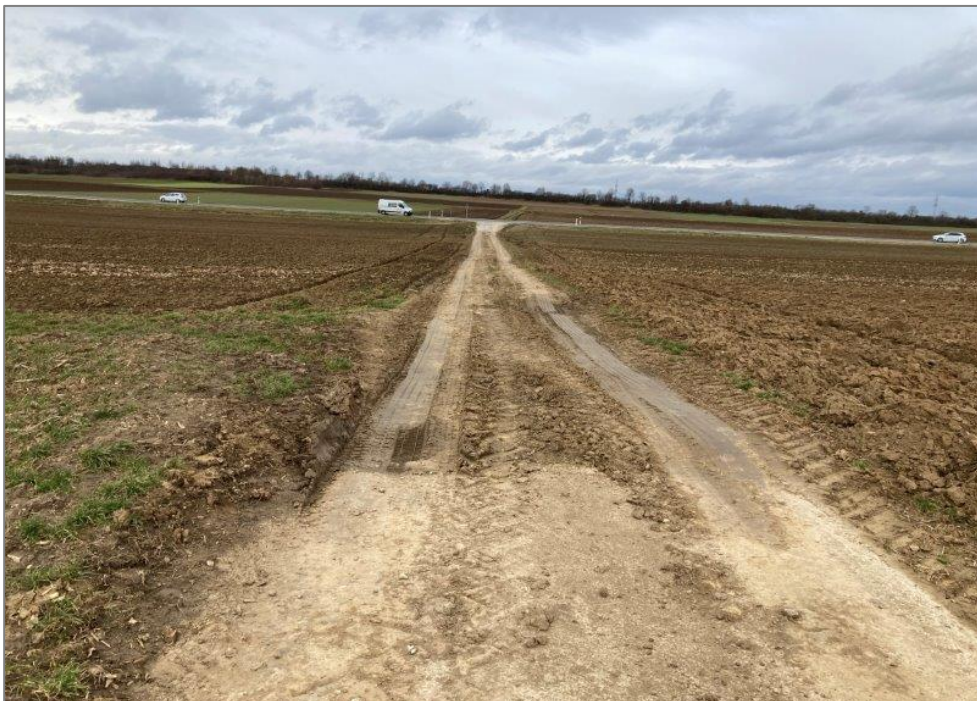
Abb. 13: Zuwegung Flst. Nr. 1279: Unbefestigter Wirtschaftsweg (nördlicher Abschnitt) (Foto: HPC AG, 07.02.2024)
