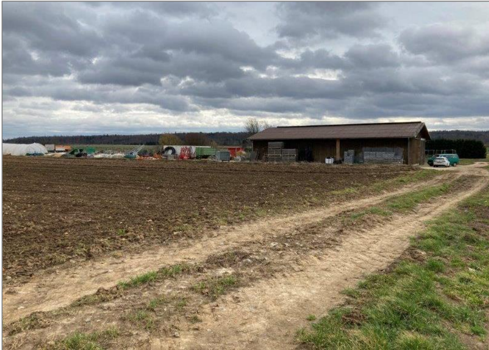
Abb. 6: Östlicher Teil SO 2: Bestandsgebäude, Lager- und Ackerflächen (Foto: HPC AG, 07.02.2024)
