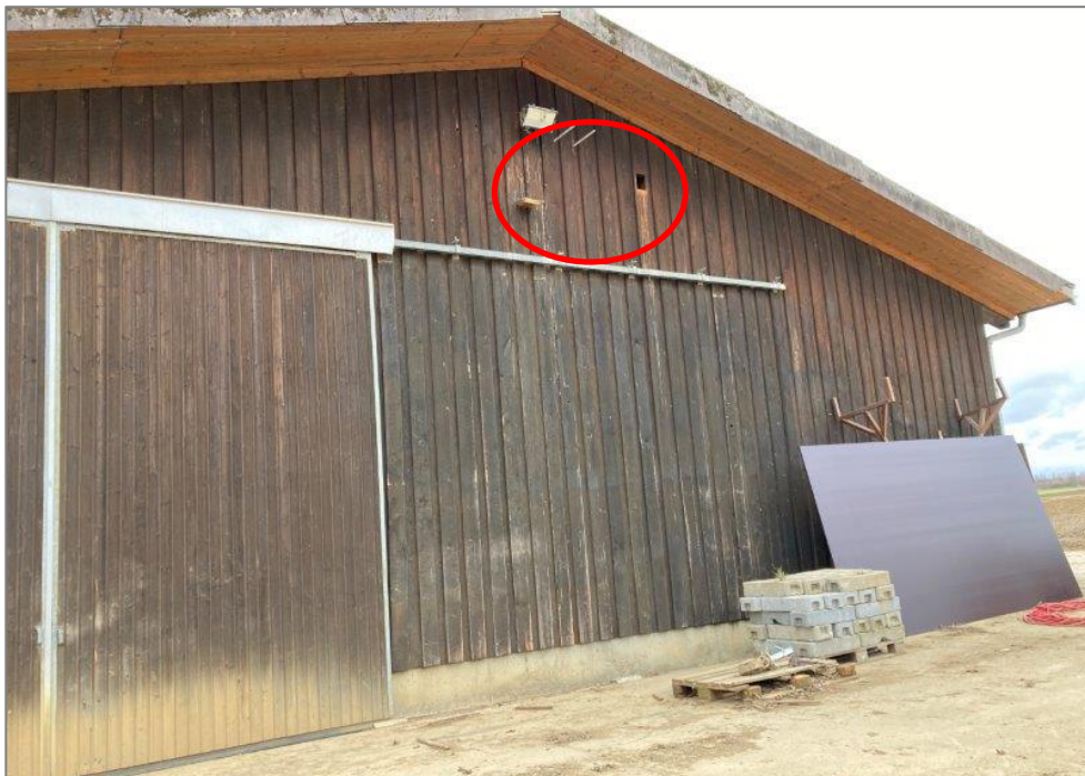
Abb. 7: Östlicher Teil SO 2: Westliche Fassade Bestandsgebäude mit Einflugloch und Ansitz für Vögel (Foto: HPC AG, 07.02.2024)
